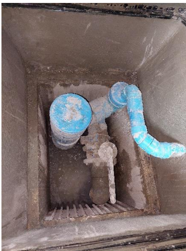
ตะแกรงดักมูลฝอยก่อนระบายออกนอกโครงการ
